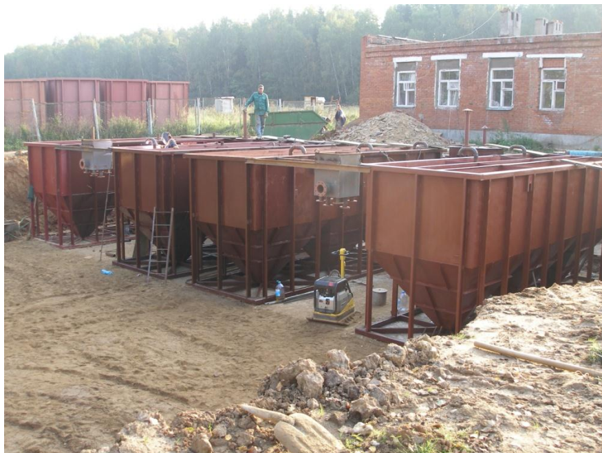
Рис.10 Монтаж вторичных отстойников
