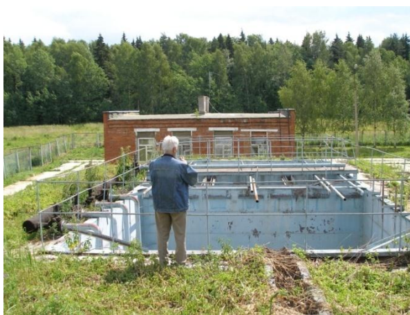
Рис.1 Станция до реконструкции
